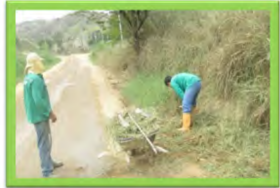
MANTENIMIENTO DE CANALES VIAS DE ACCESO
