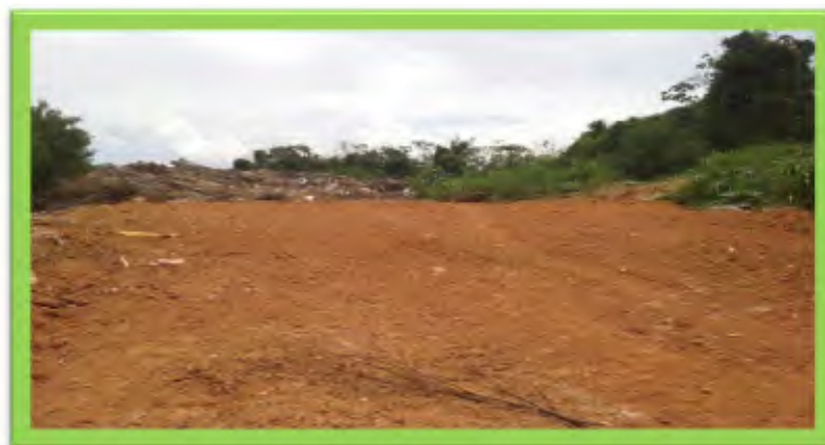
NUEVO PATIO EN LA ESCOMBRERA PARA MAYOR CAPACIDAD
