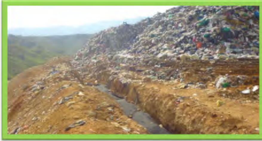
FILTRO PERIMETRAL SOBRE LA TERCERA COBERTURA DE MATERIAL ARCILLOSO
