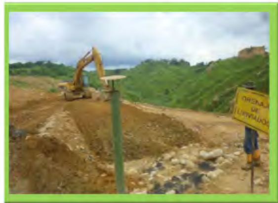
ZONA DE DESCARGUE DE LIXIVIADOS
