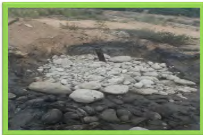
MANTENIMIENTO ZONA DE DESCARGA DE LIXIVIADOS ANTIGUA
