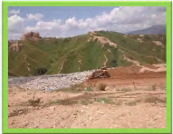
TERRAZA DE DESCARGA - TERCERA CAMA DE RESIDUOS
