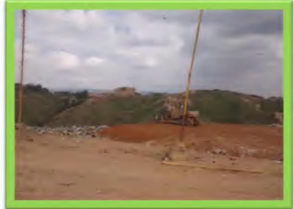
INSTALACIÓN MALLA EN LA CELDA
