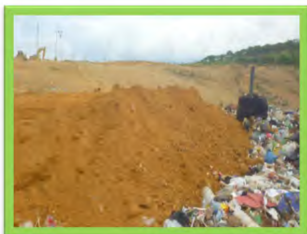
CUBRIMIENTO CON LONA TEMPORAL Y MATERIAL ARCILLOSO
