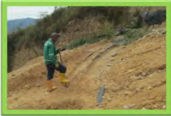
MANTENIMIENTO CANALES EN CELDA
