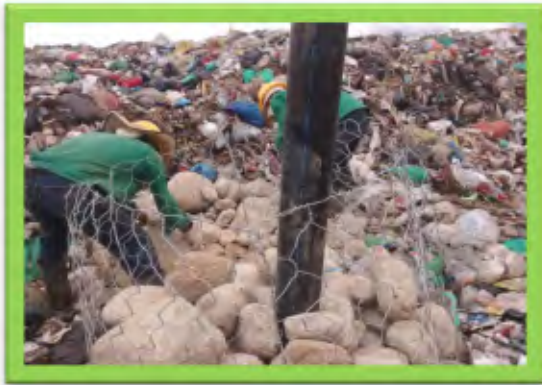
PROLONGACIÓN DE CHIMENEAS (GAVIONES PARADOS)
